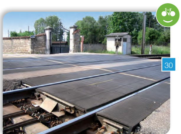
Un exemple de passage à niveau bien réalisé.
